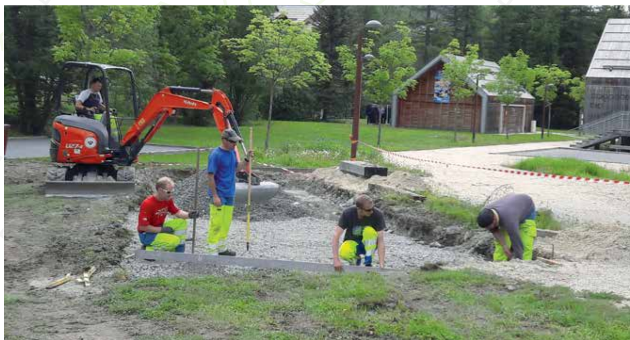
Préparation d'un nouveau terrain de boules au Parc des Colombiers
