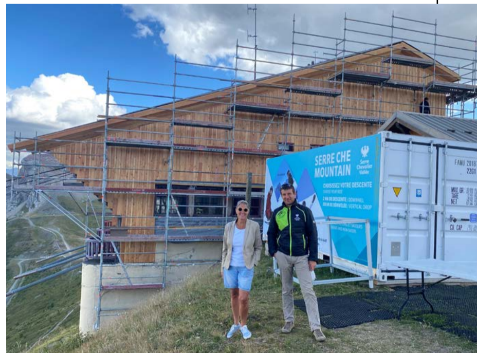
Corinne Chanfray et Patrick Arnaud sur le site du chantier.
