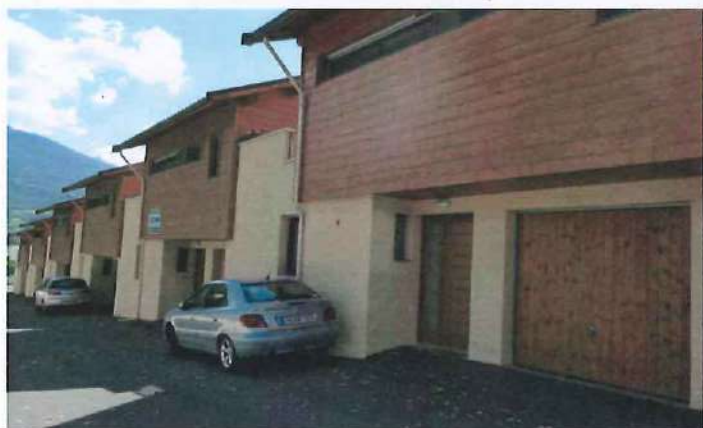
Le bois a largement été utilisé pour recouvrir les façades
