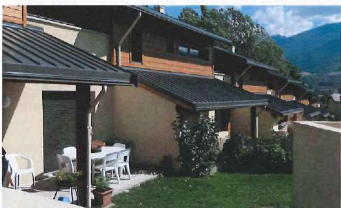
Le décalage des façades permet de créer une terrasse moins exposée aux regards des voisins
