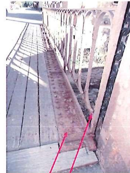
Rive amont du tablier
