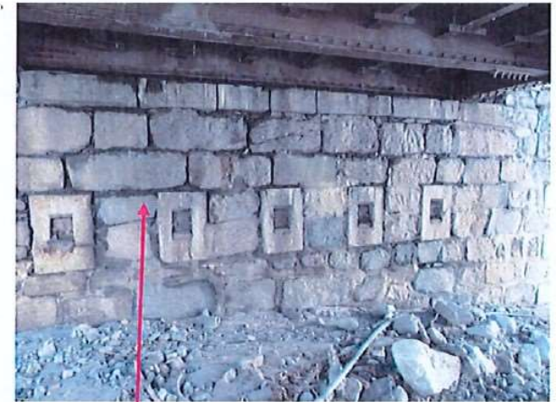
Culée rive gauche
