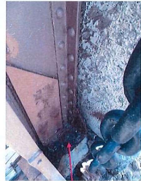
Poteau constituant la charpente supérieure
