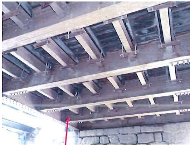
Intrados du tablier
